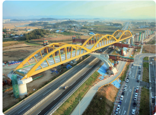
〈호남고속철 정지고가 건설현장〉
