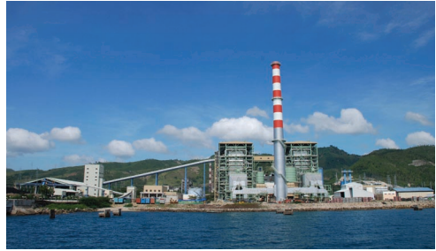
세부 유동층석탄화력발전소 전경 (사진제공 : 한국전력공사)
