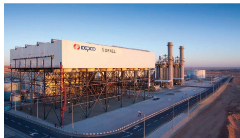
요르단 알카트라나 가스복합화력발전소 전경 (사진제공 : 한국전력공사)
