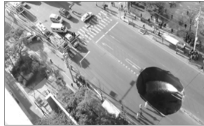
■ 도심지 지반 싱크홀 사례 (인천, 2012년)
