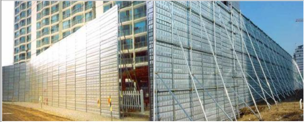
[그림 VII-13] 가설 방음 패널 설치 예시
