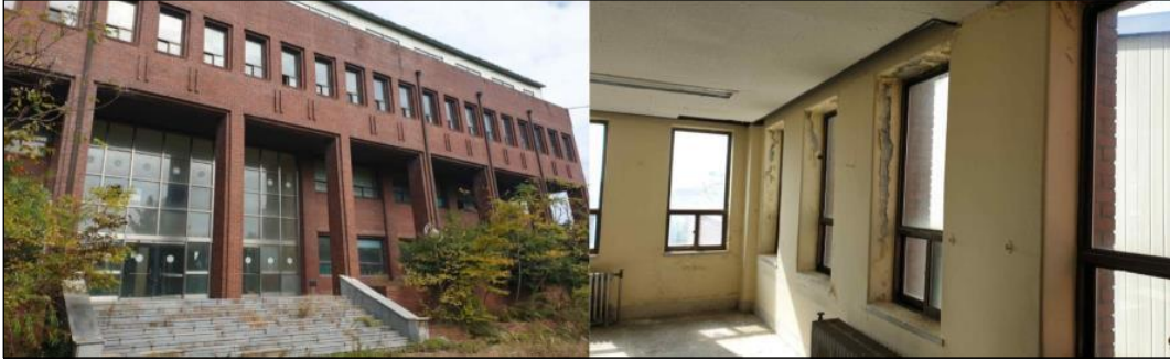
[그림 III-5] 1동(제2공학관) 외부 및 내부 오염
