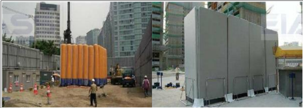
[그림 VII-14] 이동식 가설 방음 패널 설치 예시
