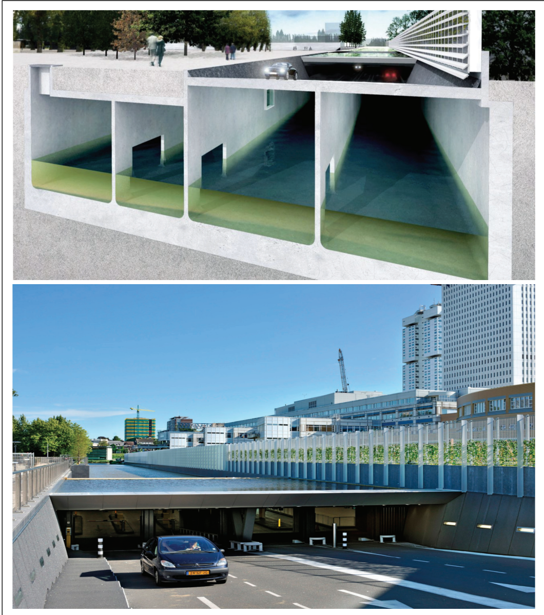
[그림 IV-39] 네덜란드 로테르담시 우수저류시설 및 주차장 활용
