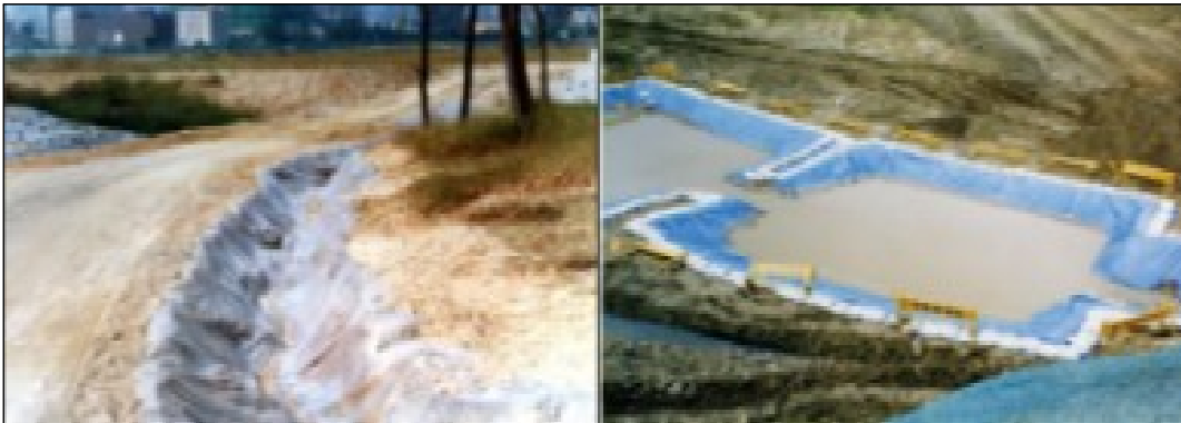
[그림 VIII-2] 가배수로 및 임시침사지 설치 예시
