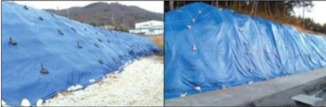
[그림 Ⅷ-3] 공사 중 비탈면 보호덮개 설치 예시
