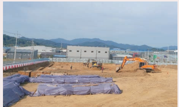
그림 2 김천 스마트 물류센터 공사 현장
