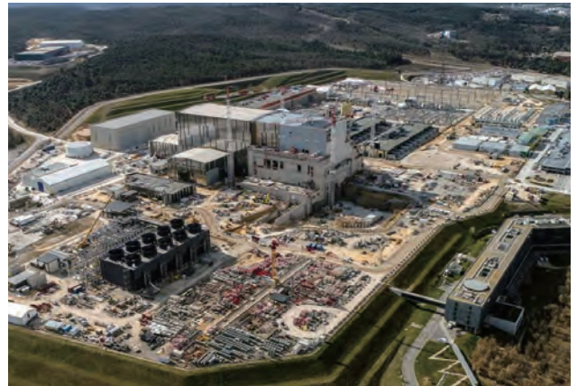
프랑스 국제핵융합실험로 건설현장 전경(사진제공: 필자)
