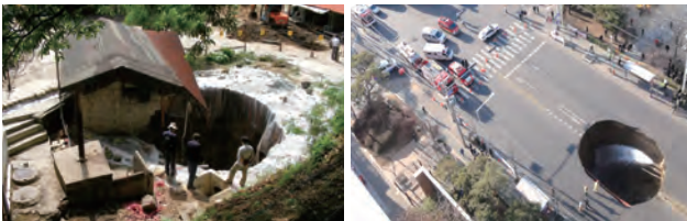
광산 지반 싱크홀 사례(충북, 2008) 도심지 지반 싱크홀 사례(인천, 2012)
